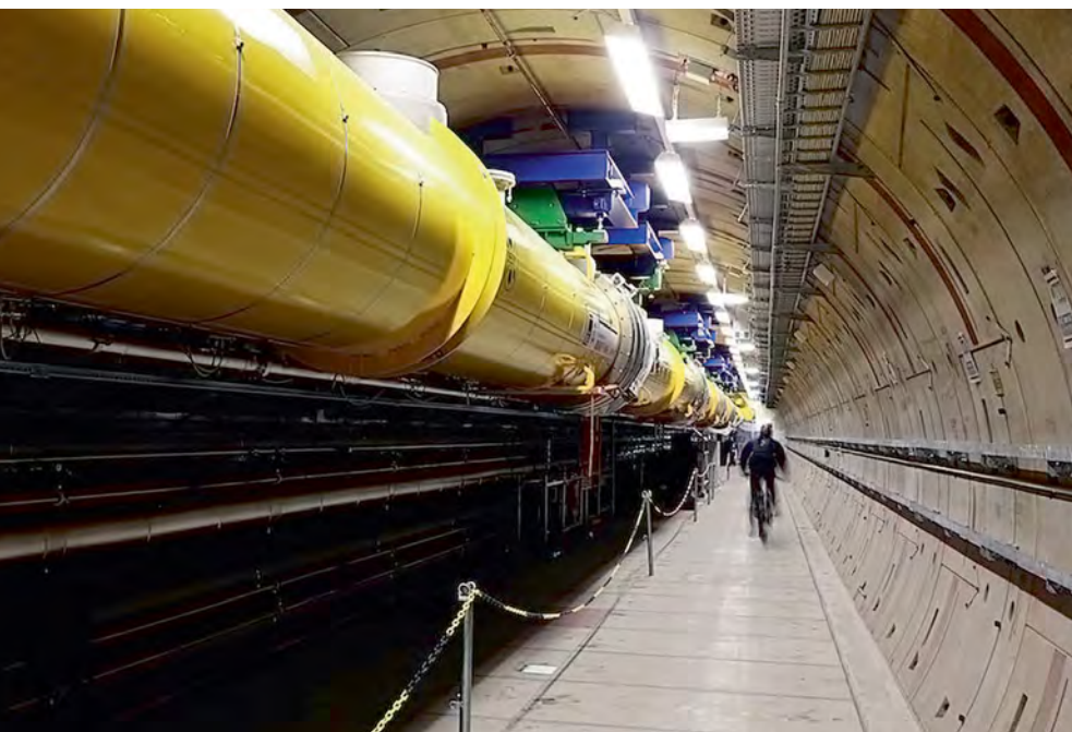
Rennstrecke für Elektronen: Im Freie-Elektronen-Laser XFEL flitzen die Teilchen durch eine 3,4 Kilometer lange Anlage zwischen dem Forschungszentrum DESY in Hamburg-Bahrenfeld und Schenefeld (oben) und erzeugen dabei Röntgenblitze. Mitarbeiter bewegen sich mit dem Fahrrad durch den Tunnel des Röntgenlasers (unten).
